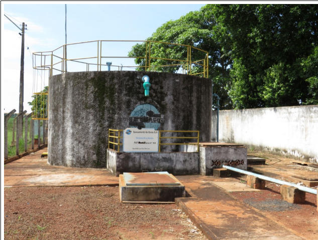
Autor: AMAE/RIO VERDE Descrição: Reservatório Apoiado (RAP) Riverlândia
