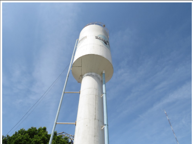
Autor: AMAE/RIO VERDE Descrição: Reservatório Elevado (REL) Riverlândia
