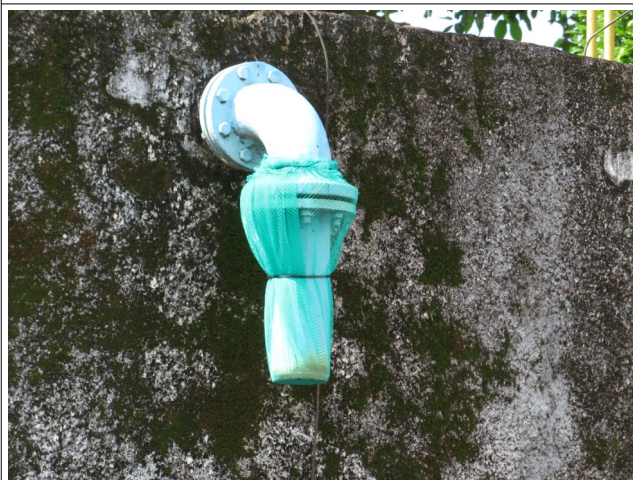
Autor: AMAE/RIO VERDE Descrição: Tubo extravasor RAP fechado com tela.
