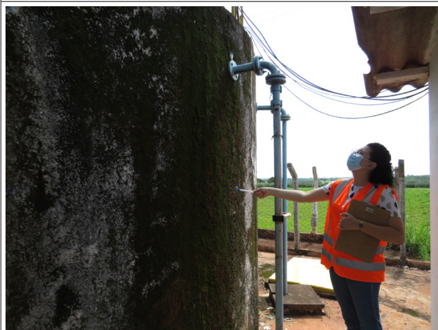
Autor: AMAE/RIO VERDE Descrição: Presença de lodo na superfície externa do RAP.
